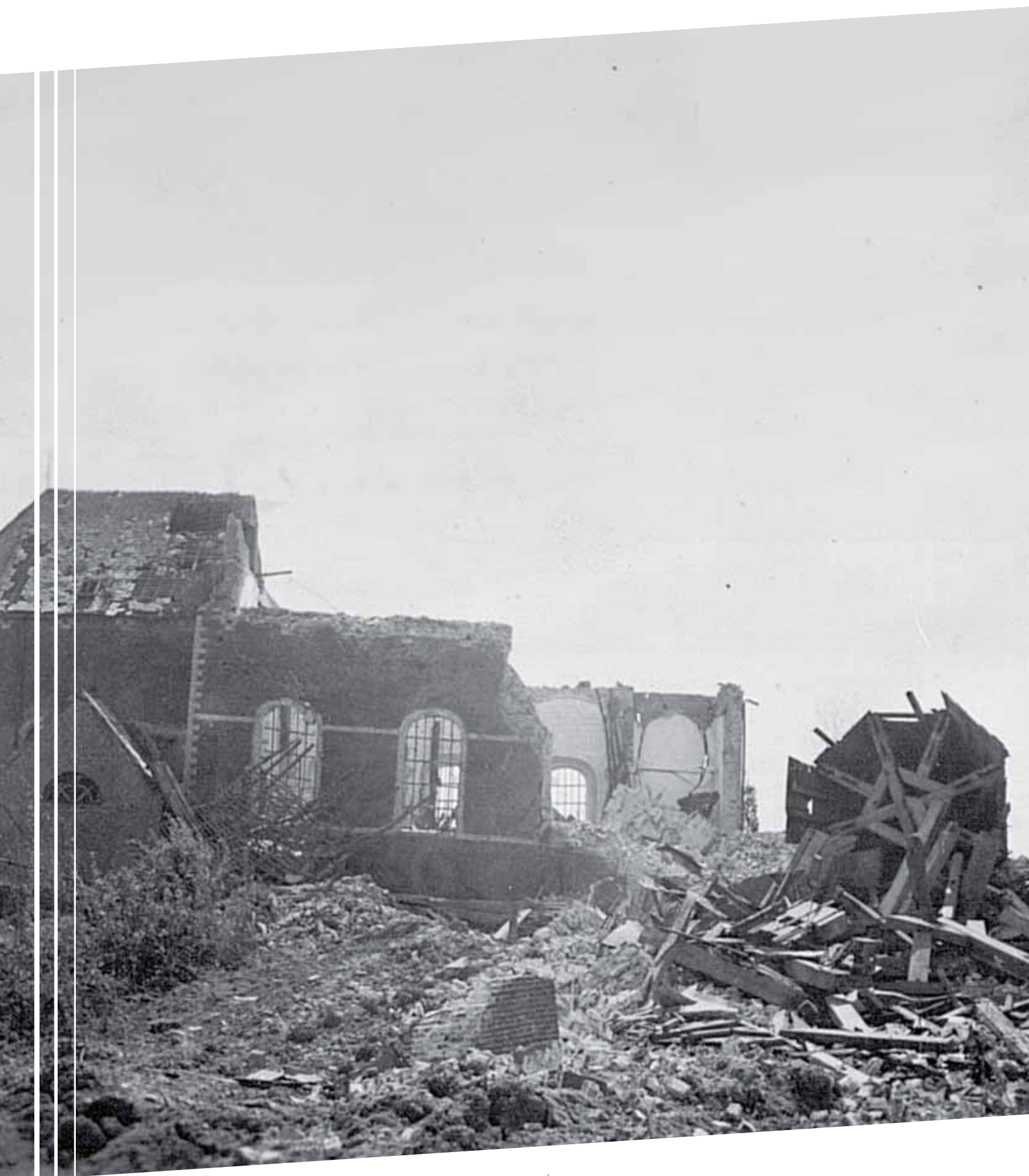
FOTO DIE DE SCHADE AAN DE KERK SAINT-GÉRY TE LIMELETTE WEERGEeft.
