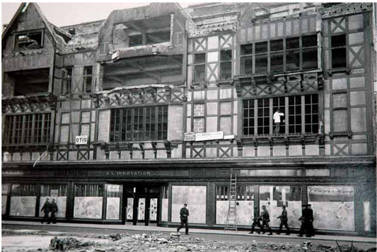
ZICHT OP DE ZWAAR BESCHADIGDE GEVEL VAN DE INNOVATION IN OOSTENDE.
